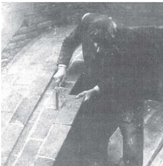
*Figure 2.2.3 - Construction d'une paillasse d'escalier selon la technique de la voûte catalane dans [11, p. 60]*
