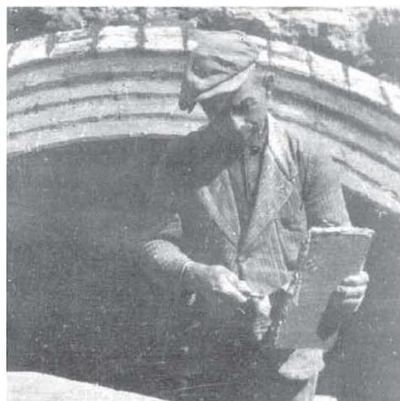
*Figure 2.2.4 – Construction d'une voûte catalane. Application du mortier sur les deux chants de la brique dans [11, p. 59]*
