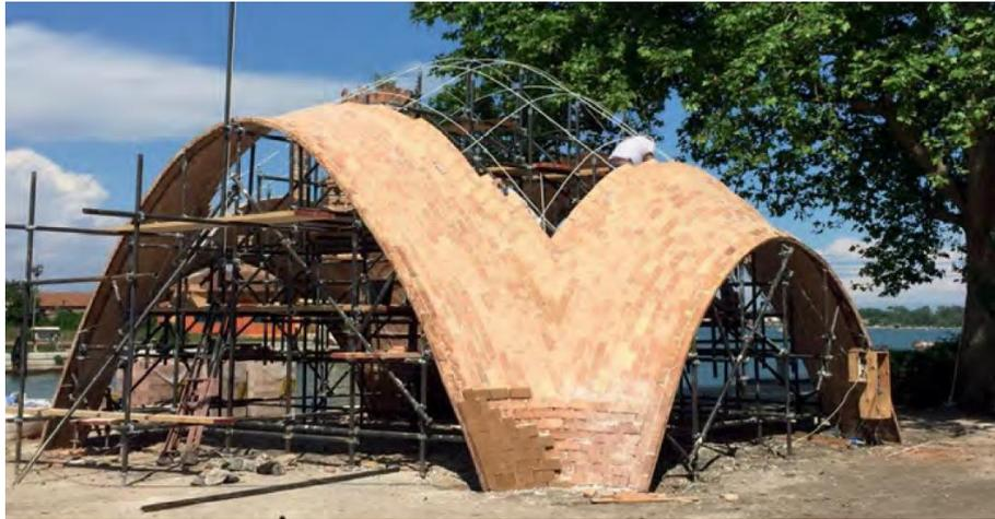
Figure 1.1.7 – La voûte en construction à Venise. Démarrage 2<sup>ème</sup> et 3<sup>ème</sup> couche. Dans [4, p. 49].
