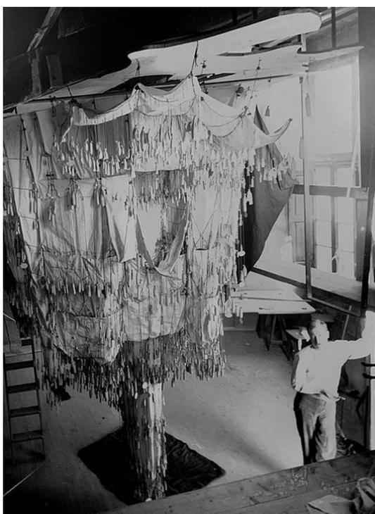
Figure 3.2.2 - Gaudí avec le modèle suspendu de la Colònia Güell<sup>1</sup>
