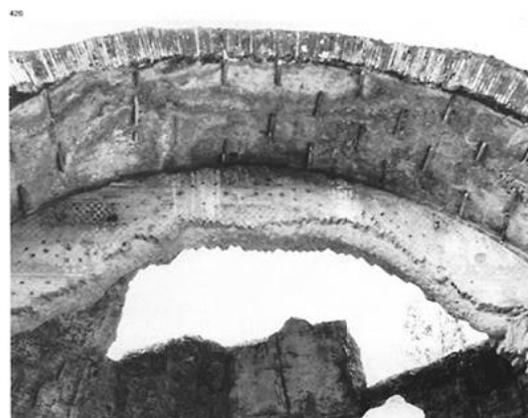
Figure 2.2.9 - Restes d'une voûte en opus caementicum dans les thermes de Caracalla. On note les traces des briques sur chant qui sont visibles depuis que le parement constitué par le couchis s'est effondré ; Jean-Pierre Adam ; op.cit.
